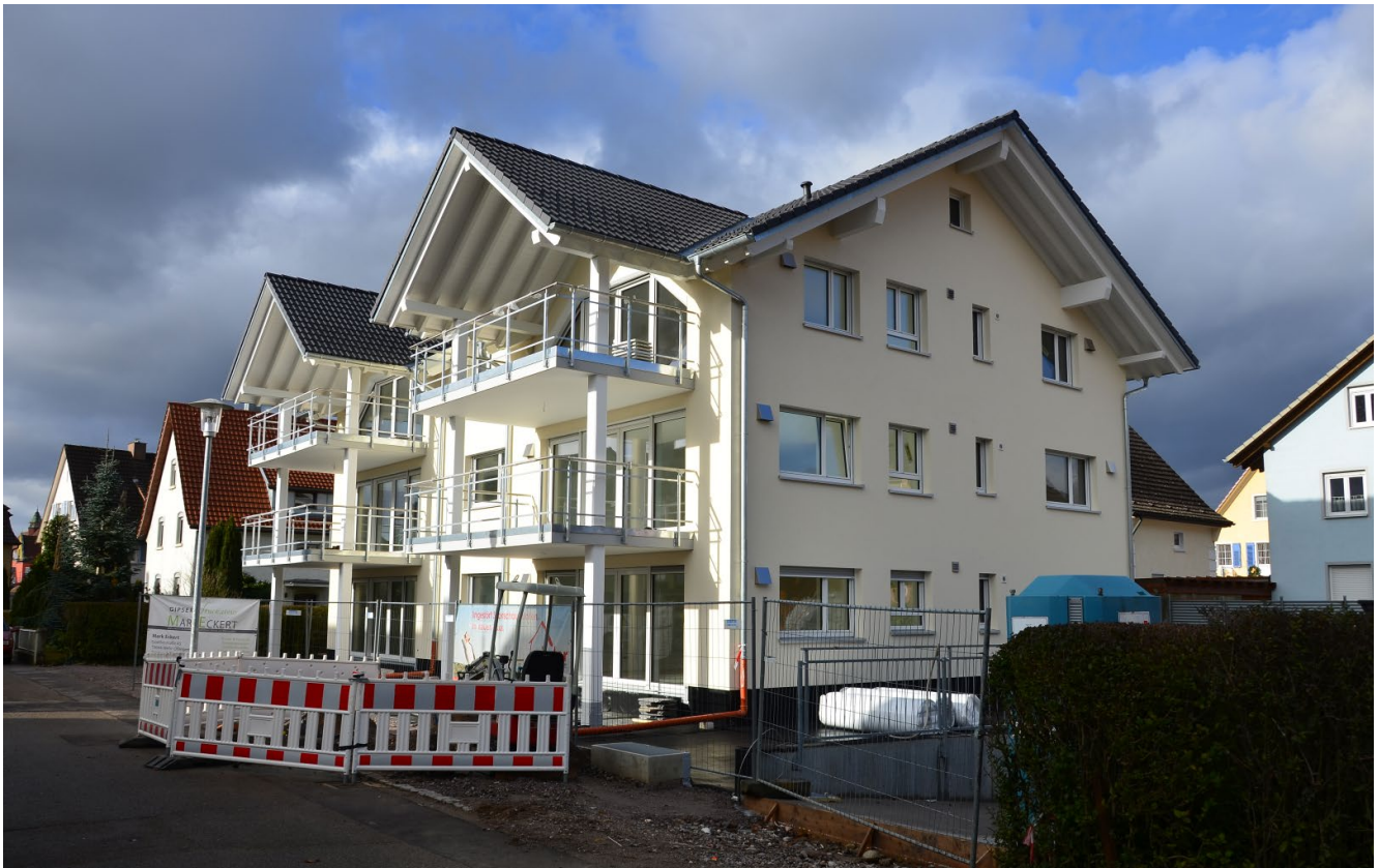
Bild 13. Neubau Wohnhaus in Murg
