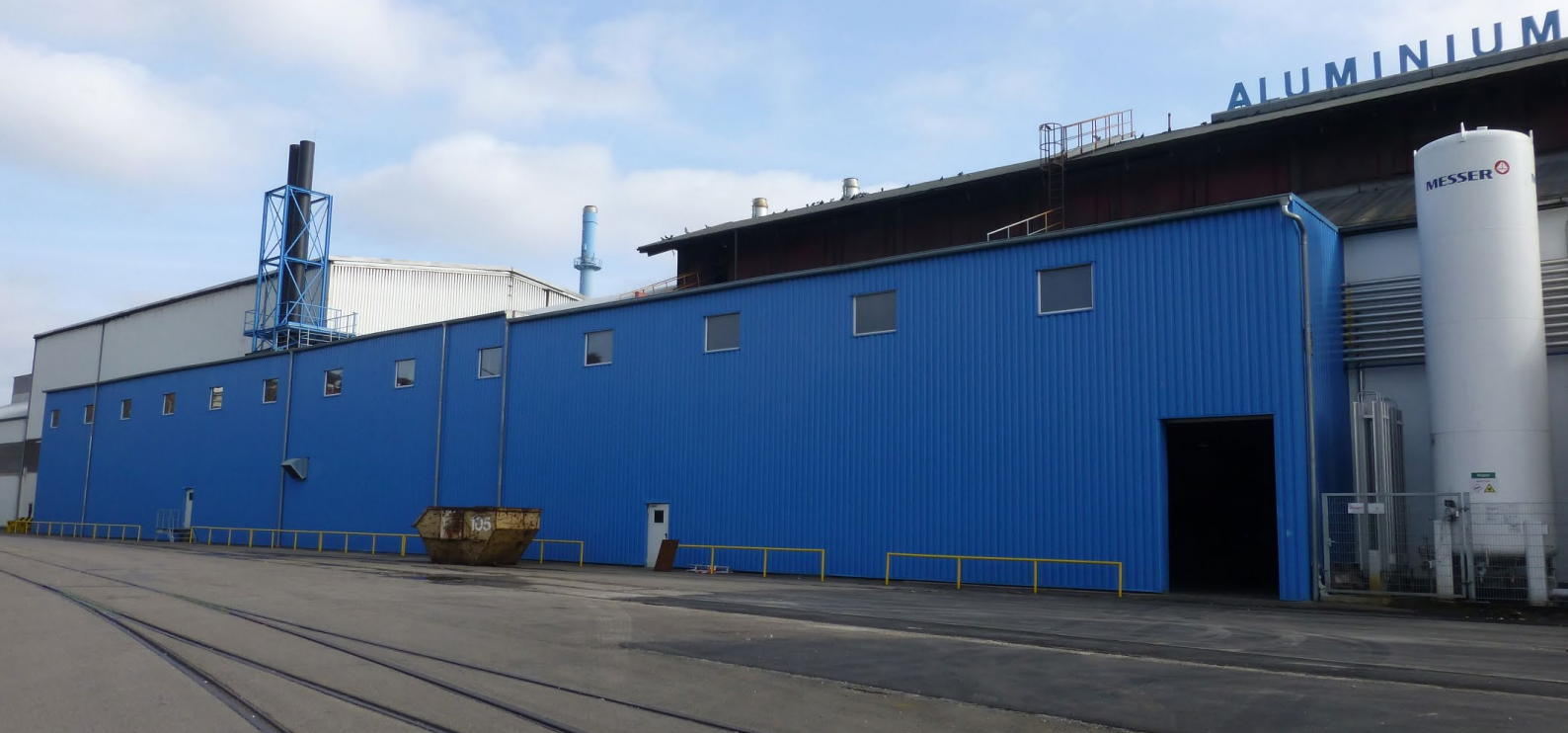
Bild 1. Anbau mit Silo-Behältern, Aluminium Rheinfelden
