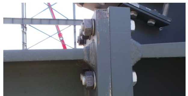
Bild 6. Beispiel eines Trägerstoßes (dicke Kopfplatten)
