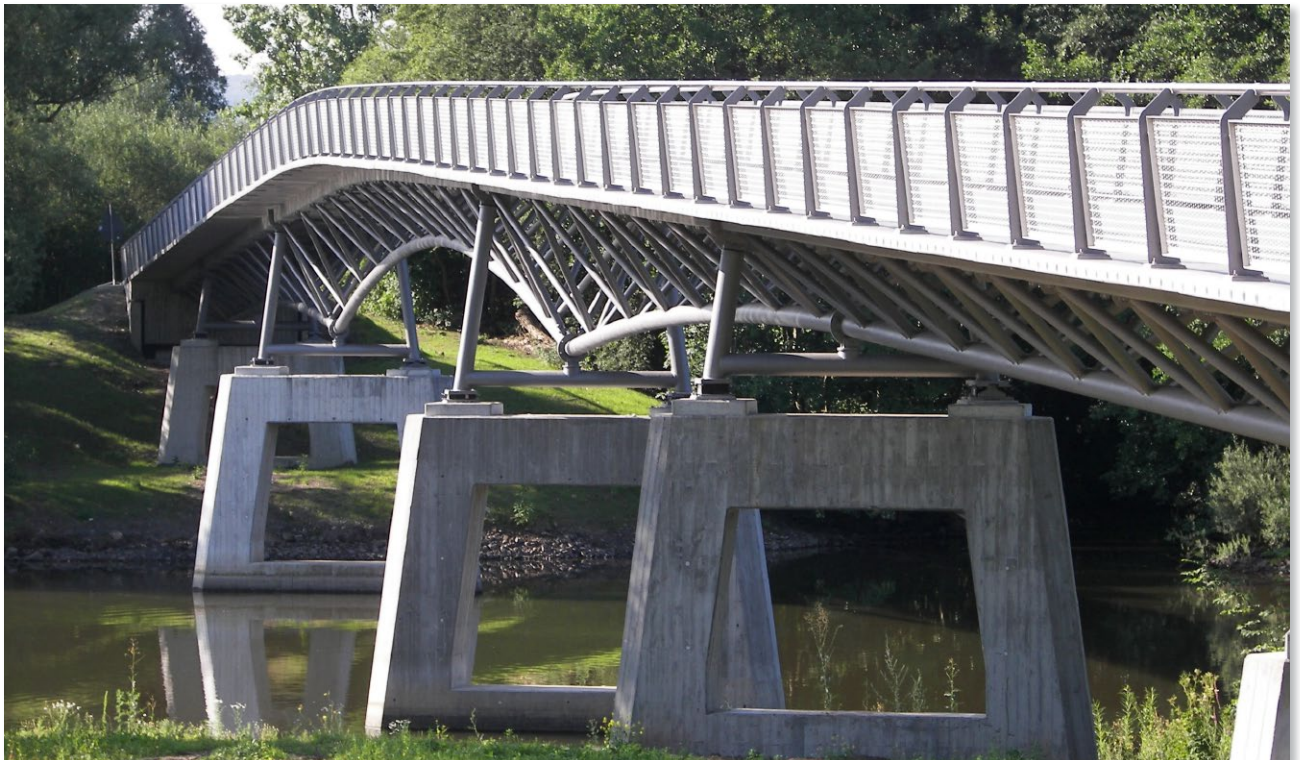
Bild 1. Gärtnerplatzbrücke über die Fulda in Kassel mit einem Obergurt aus ultrahochfestem Beton
