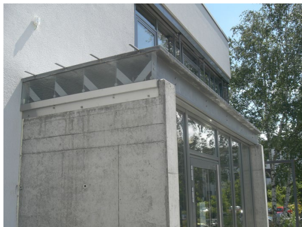
Bild 2. Vordach des ETA-Gebäudes der TU Kaiserslautern
