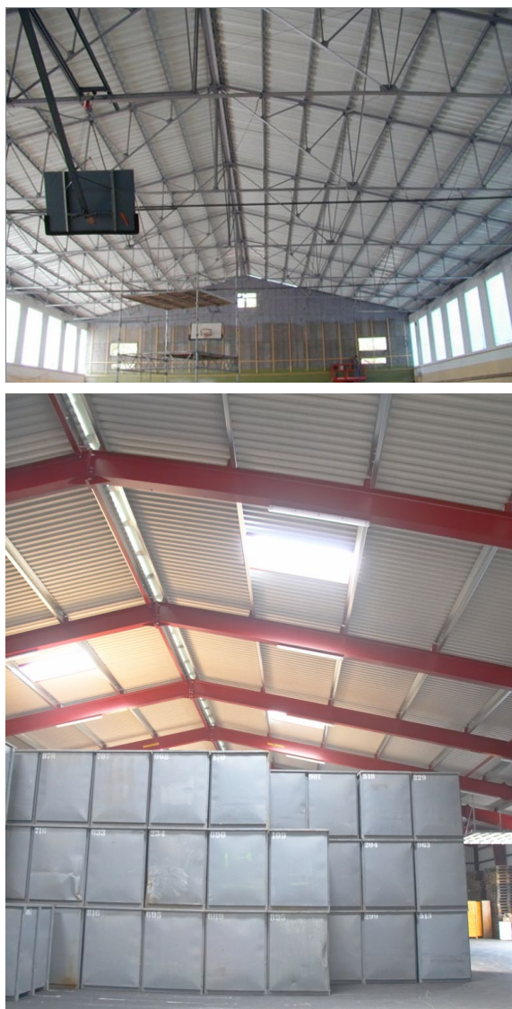
Bild 1. a) Turnhalle sowie b) Lagerhalle mit Stahltrapezprofilen als Dachdeckung [Foto: Hoesch]
