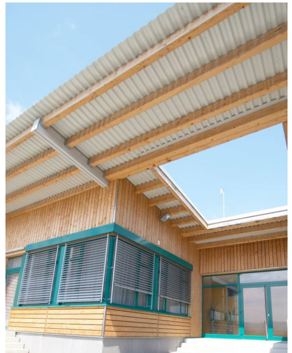
Trapezprofildach mit Unterkonstruktion Holzträger [Foto: Hoesch]
