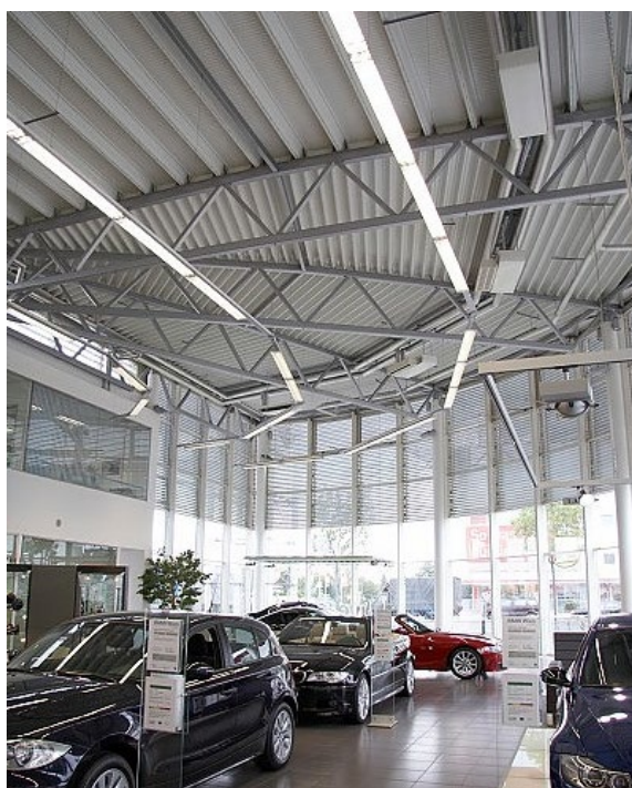
Bild 8. Trapezprofile mit großer Spannweite von Binder zu Binder [Foto: Hoesch]
