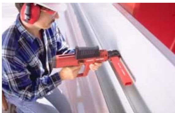
Befestigung der Trapezprofilbleche mit Setzbolzen [Foto: Fischer]
