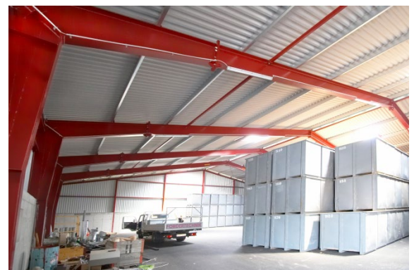
Bild 7. Trapezprofile mit Spannweiten von Pfette zu Pfette [Foto: Hoesch]
