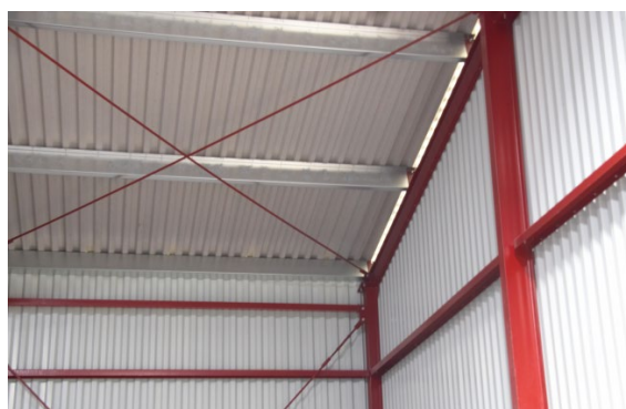
Bild 3. Halle mit Dach- und Wandaufbau aus Trapezprofilen [Foto: Hoesch]
