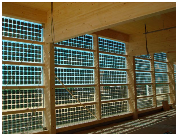
Auch im Innenbereich setzt die moderne Energietechnik Akzente: Mensafassade von innen
