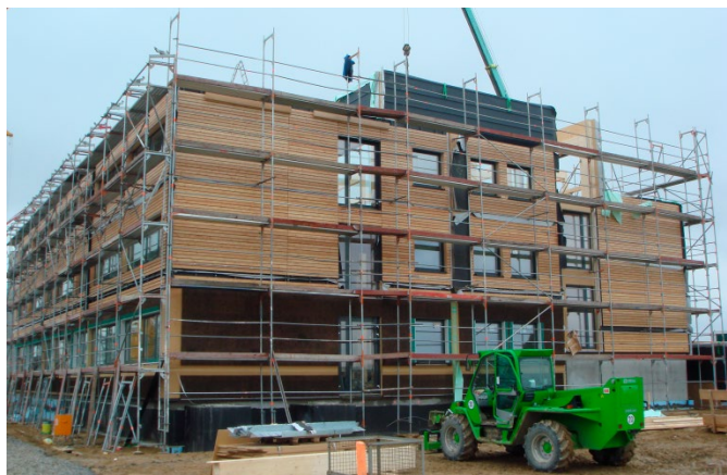
In einer Rekordzeit von nur 6 Monaten wurde der aus drei Teilen bestehende Bürokomplex in moderner Holzbauweise fertig gestellt
