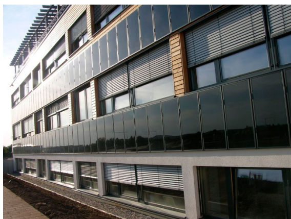
... als auch die Fassadenflächen sorgen mit einer Solarzellen-Gesamtfläche von 2.100 Quadratmetern für einen Jahresertrag von rund 220.000 kWh
