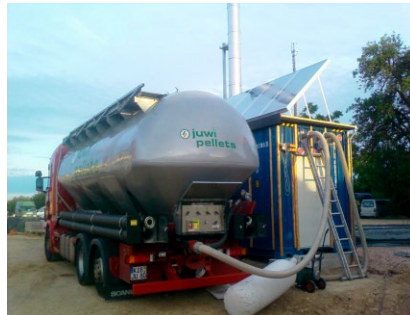
Eine externe, auf Bio- und Solarenergie basierende Energiekabine, sorgt für die umweltfreundliche Wärmeversorgung des Gebäudes: Anlieferung der Pellets
