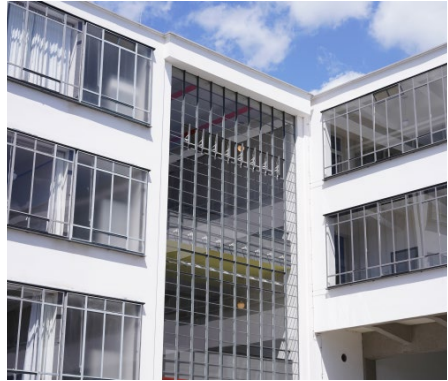
Bild 3. Eingang Nordflügel mit angrenzender Brücke
