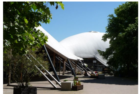
Bild 7. Stahlseile an den Fußpunkten
