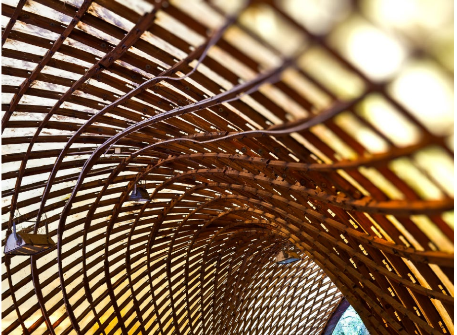
Bild 6. Hochkomplexe Dachstruktur im Detail
