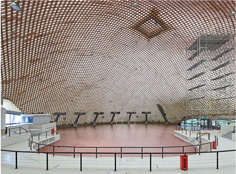
Bild 4. Innenraum der Veranstaltungshalle mit Tribünen und Gitterschale
