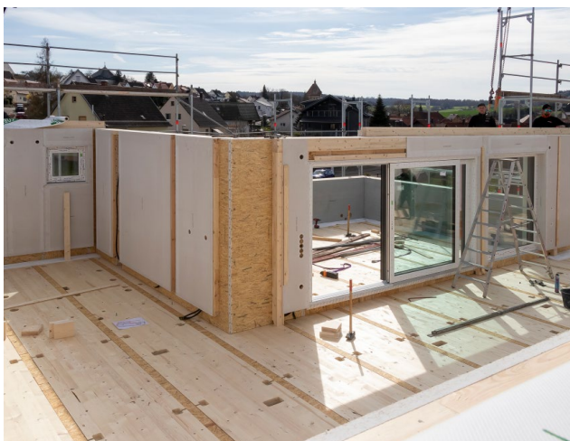
Bild 14. Blick auf die Terrasse im 2.OG
