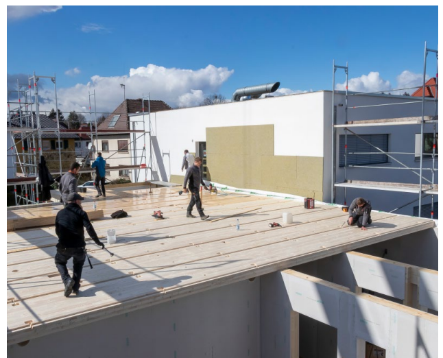
Bild 7. Montage der Brettsper Holzdecke über dem EG
