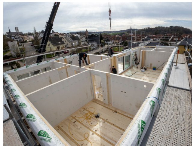
Bild 12. Fertigstellung der Holzständerwände im 2.OG
