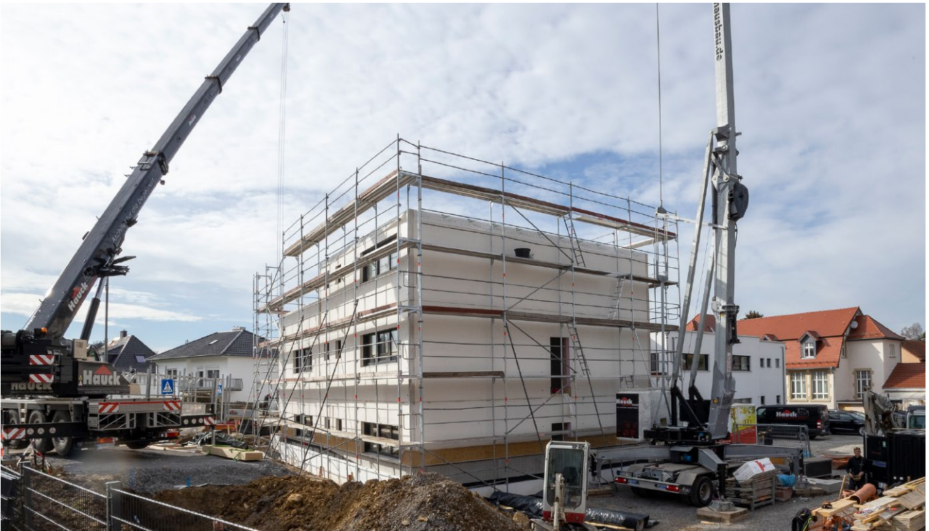
Bild 8. Blick auf den Büroanbau
