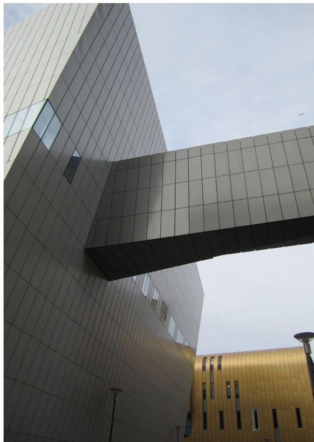
Zugang des Labors über eine frei tragende Brücke
